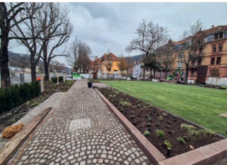
Porphyrpflaster beim Einbau auf der Baustelle Montpellierplatz in Heidelberg als durchgehender Weg mit Verlegung in Segmentbögen mit seitlichen Nischen in Reihe. Foto: Gramenz GmbH GaLaBau
