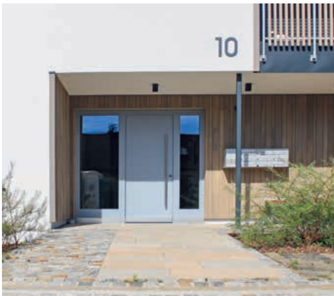
Das recycelte Kopfsteinpflaster wird mit einer breiten Bahn aus Platten barrierefrei angelegt. Fotos: freisign
