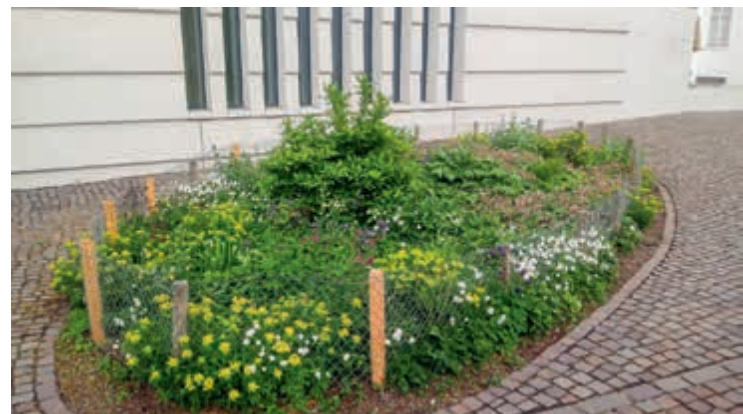
Links: Kleinpflasterfläche vor einem Museum, in Reihe verlegt. Rechts: Die Pflanzinsel innerhalb der Porphyrpflasterdecke ist mit einem einzelnen Randabschluss (in Beton mit Rückenstütze) eingefasst.
