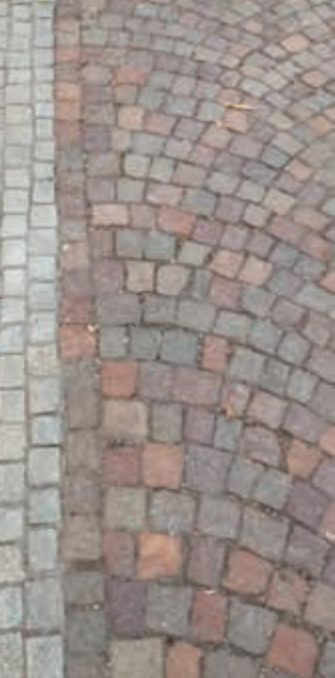
Links: Randausbildung einer Porphyrpflasterfläche, hier im Übergang mit Belagswechsel zu Granit. Rechts oben: Das fünfzeilige Pflasterband gliedert eine Grossfläche.
