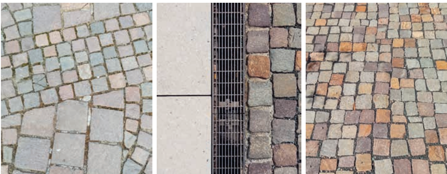
Links: Dreizeiliges Gross- und fünfzeiliges Kleinpflasterband kreuzen beziehungsweise durchdringen sich. Das kleine Format läuft durch, das grosse wird unterbrochen. Mitte: Pflaster im Übergang zu Betonplatten mit einer Entwässerungsrinne. Die Zeile direkt vor der Rinne wurde aus Stabilitätsgründen vermörtelt. Rechts: Pflaster mehr oder weniger in Reihen beziehungsweise in leicht wildem Verband verlegt. Die mit Splitt verfüllten Fugen sorgen für Wasserdurchlässigkeit und Ökologie.
