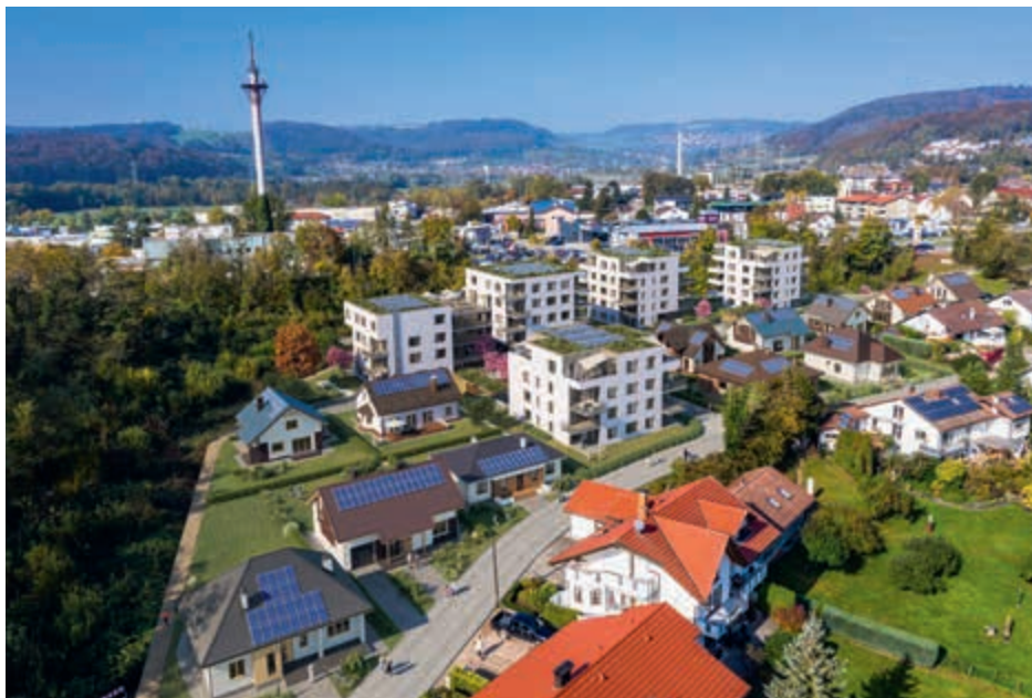
Das Luftbild zeigt die städtebauliche Einbettung des neuen Quartiers «Am Kaltenbach» mit den vier Mehrfamilienhäusern entlang des Talbachs. Im Süden spannt sich zwischen zwei Gebäuden der Quartiersplatz auf. Foto: Oekogeno; Plan: freisign
