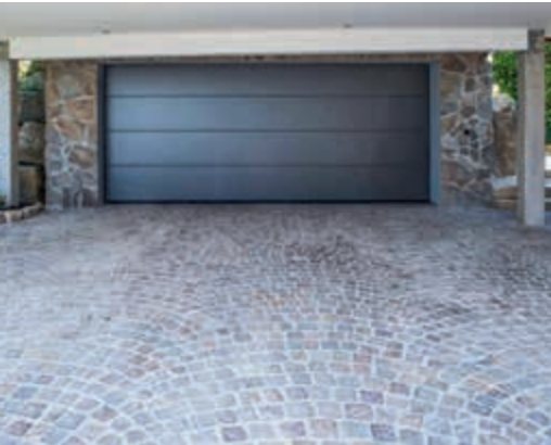
Als Belag einer Rampe über einer Tiefgarage ist diese Fläche in Segmentbögen gepflastert. Die Fugen sind leicht eingetieft vermörtelt, sodass die Bogenstruktur gleichzeitig auch der Entwässerung dient. Am Fusspunkt der Rampe liegt quer eine Rinne.
