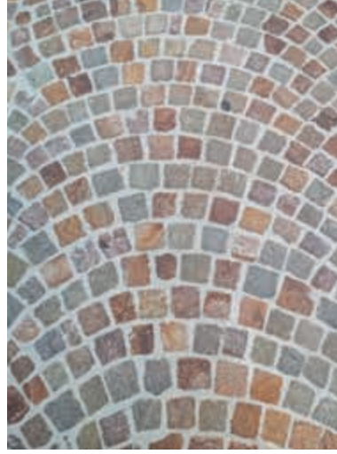
Als Belag einer Rampe über einer Tiefgarage ist diese Fläche in Segmentbögen gepflastert. Die Fugen sind leicht eingetieft vermörtelt, sodass die Bogenstruktur gleichzeitig auch der Entwässerung dient. Am Fusspunkt der Rampe liegt quer eine Rinne.
