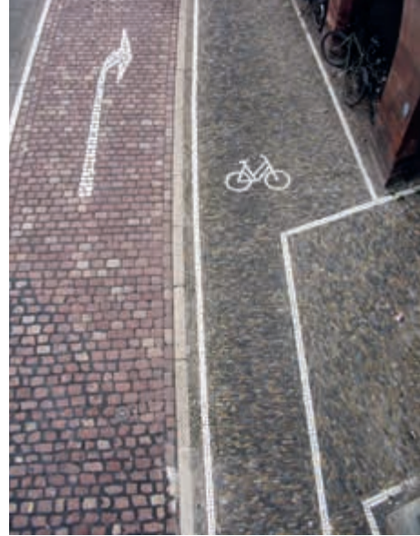
Oben: In Freiburg im Breisgau wurde für die Fahrspuren jeweils ein eigener Belag gewählt. Die linke PKW-Spur hat eine Porphyr-Decke, die Velospur halbierte Rheinkiesel.
