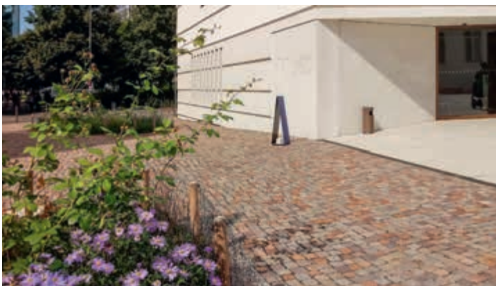
Links: Kleinpflasterfläche vor einem Museum, in Reihe verlegt. Rechts: Die Pflanzinsel innerhalb der Porphyrpflasterdecke ist mit einem einzelnen Randabschluss (in Beton mit Rückenstütze) eingefasst.
