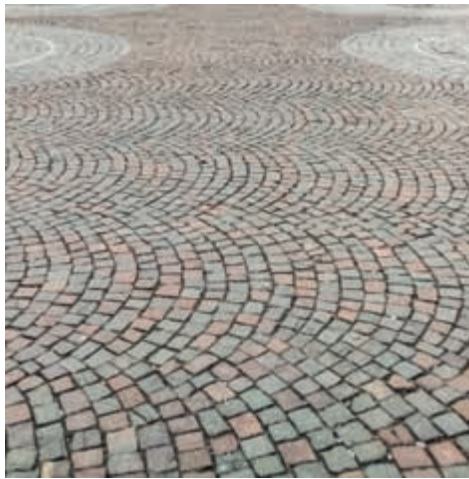
Links: Detail einer Grosspflasterfläche (Segmentbögen). Mitte/rechts: Gliederung von Grosspflasterflächen mit anderen Materialien oder Bändern.
