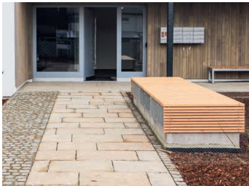
Die Bank aus einem aufbereiteten Betonfertigteile mit Holzaufgabe kaschiert unauffällig die Lüftungen einer Tiefgarage.
