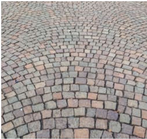
Links: Detail einer Grosspflasterfläche (Segmentbögen). Mitte/rechts: Gliederung von Grosspflasterflächen mit anderen Materialien oder Bändern.
