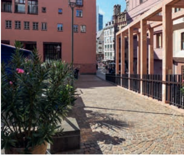
Als Belag einer Rampe über einer Tiefgarage ist diese Fläche in Segmentbögen gepflastert. Die Fugen sind leicht eingetieft vermörtelt, sodass die Bogenstruktur gleichzeitig auch der Entwässerung dient. Am Fusspunkt der Rampe liegt quer eine Rinne.
