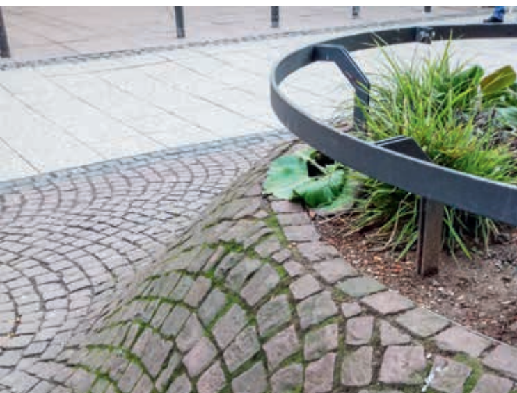
In den 80er-Jahren waren runde Hochbeete, die sich aus der Pflasterung entwickeln, sehr modern. Ein Baum sitzt mittig in Schachtringen, die aussen ein schräges Betonbett erhalten. Die Konstruktion wird mit dem gleichen Porphyrstein «weich» aus der Fläche in die Höhe gepflastert.
